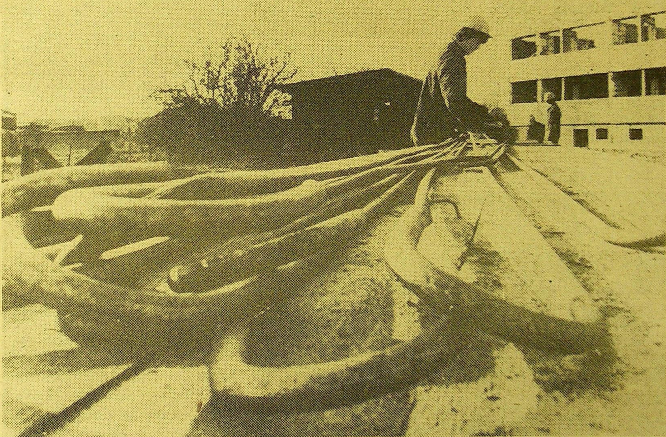
Czesław Fabiszewski obsługuje urządzenie do gięcia prętów zbrojeniowych.
