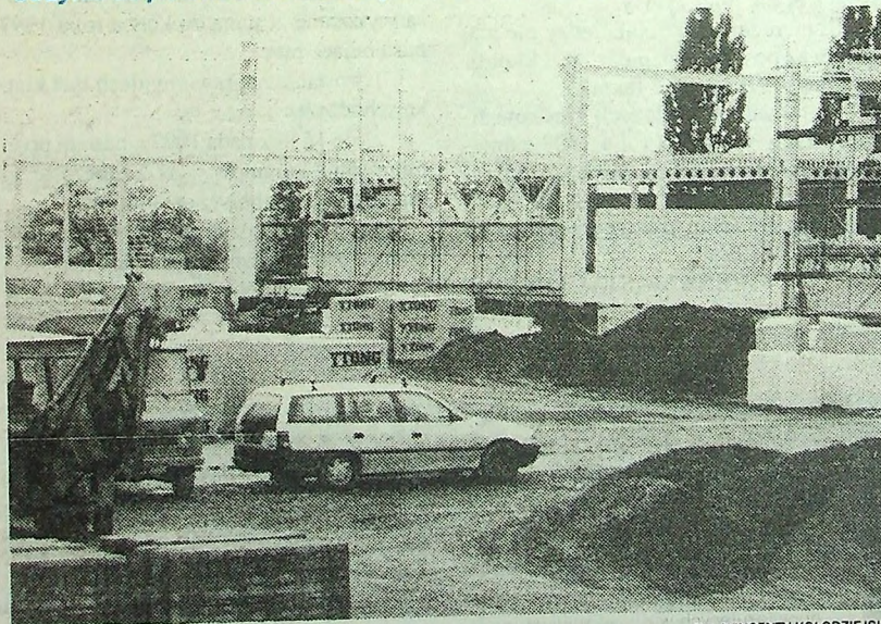
Budowa supermarketu w Lubinie.
