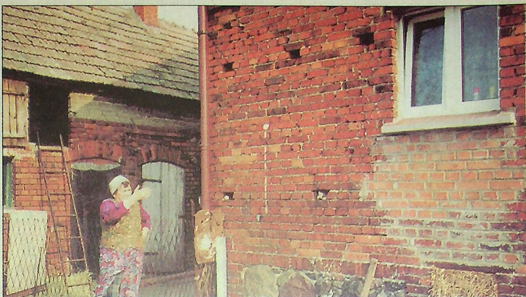
Sabina Lech za własne pieniądze wyremontowała popękany dom.
