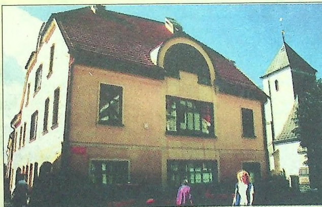
Budynek Miejskiej Strefy Usług Publicznych, siedziba przyszłego starostwa.
