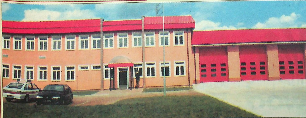
Nowy budynek Straży Pożarnej w Polkowicach.
