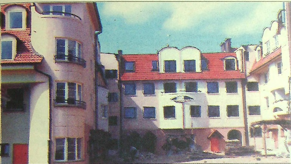
Pierzeja południowa Starego Miasta. Ostatnie prace przed przekazaniem mieszkań i lokali użytkowych właścicielom.
