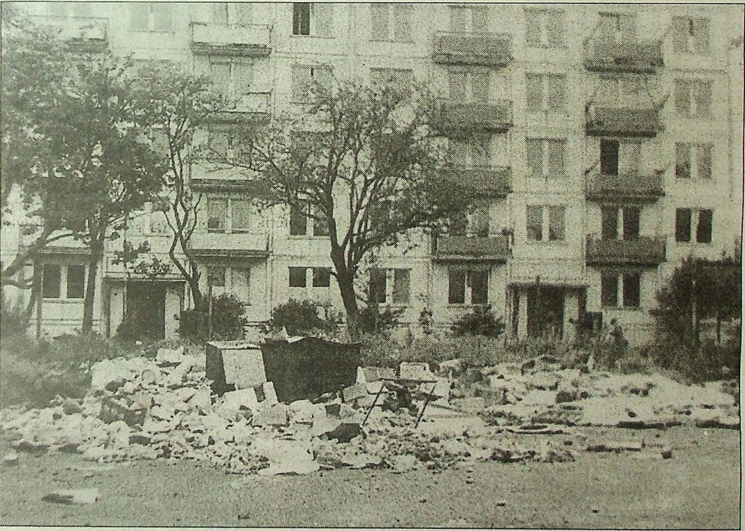
... i przed remontem
