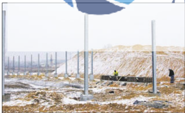
Te słupy w przyszłości staną się filarami ekranów akustycznych
