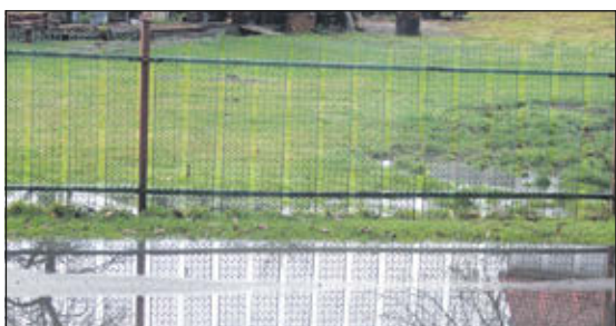
Wcześniej problem nasilał się tylko kiedy spadł deszcz, a zimą w czasie odwilży. Ale ostatnio ścieki wybijają nawet gdy jest sucho
