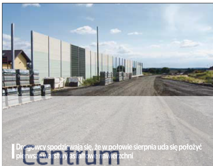
W kierunku ulicy Hutniczej przygotowana jest podbudowa z kruszywa kamiennego pod warstwy bitumiczne
