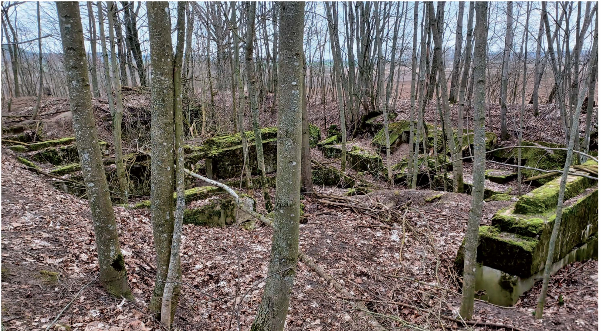
▲ Ruiny schronu w dziele piechoty blokującym przeprawę przez Kanał Mioduński
