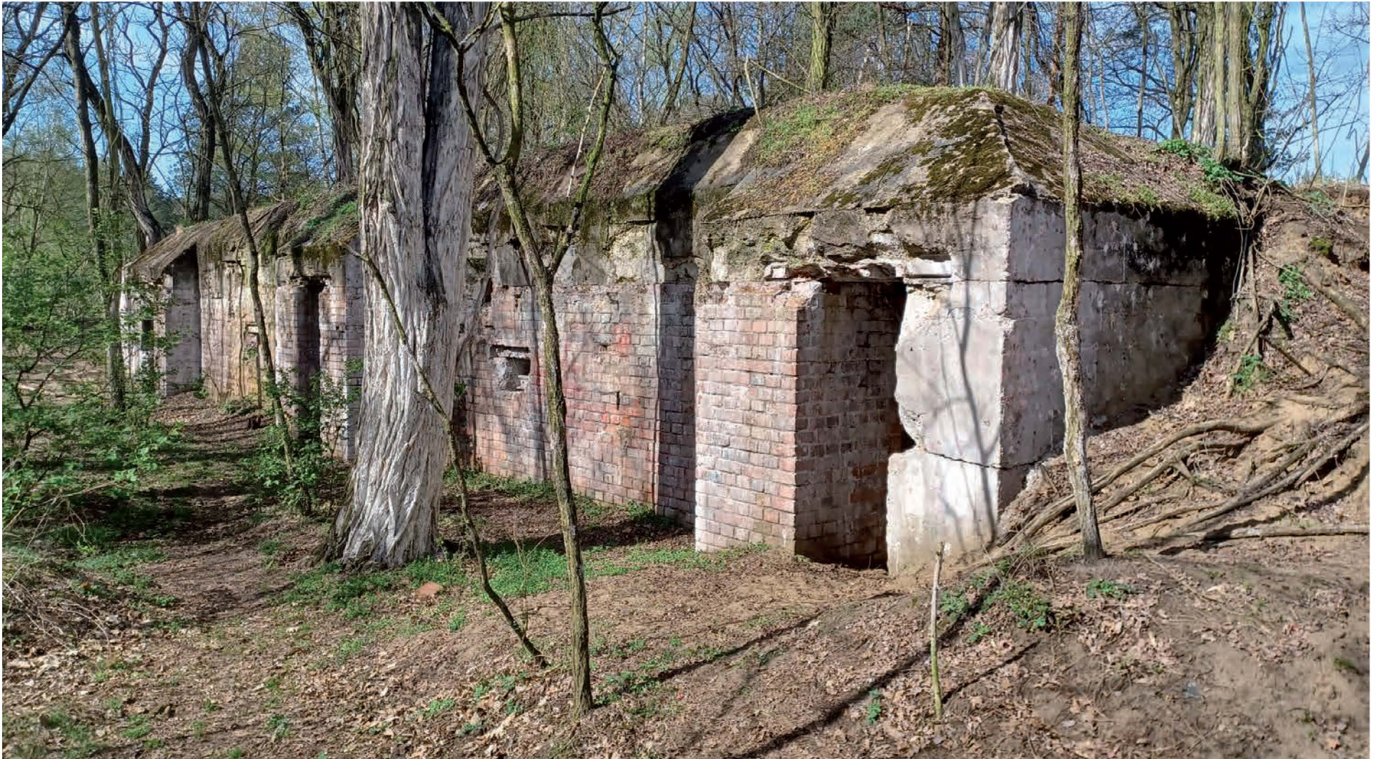
▲ Schron piechoty na jednym z szanćów po wschodniej stronie Głogowa
