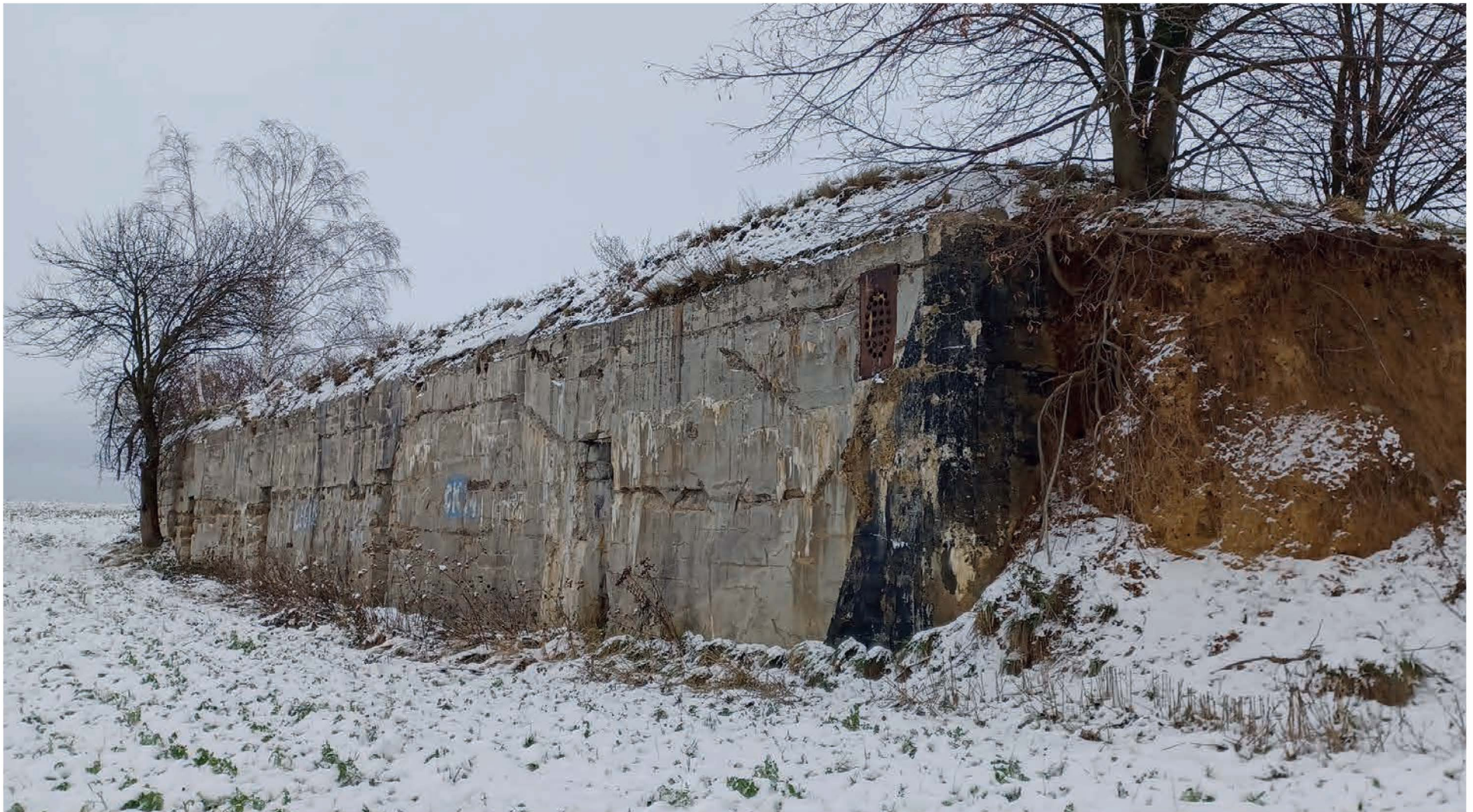
▲ Schron piechoty zbudowany w nowym pasie fortyfikacji grudziądzkich w latach 1913–1914, prawdopodobnie w miejscu planowanej festy (grupy fortowej)
