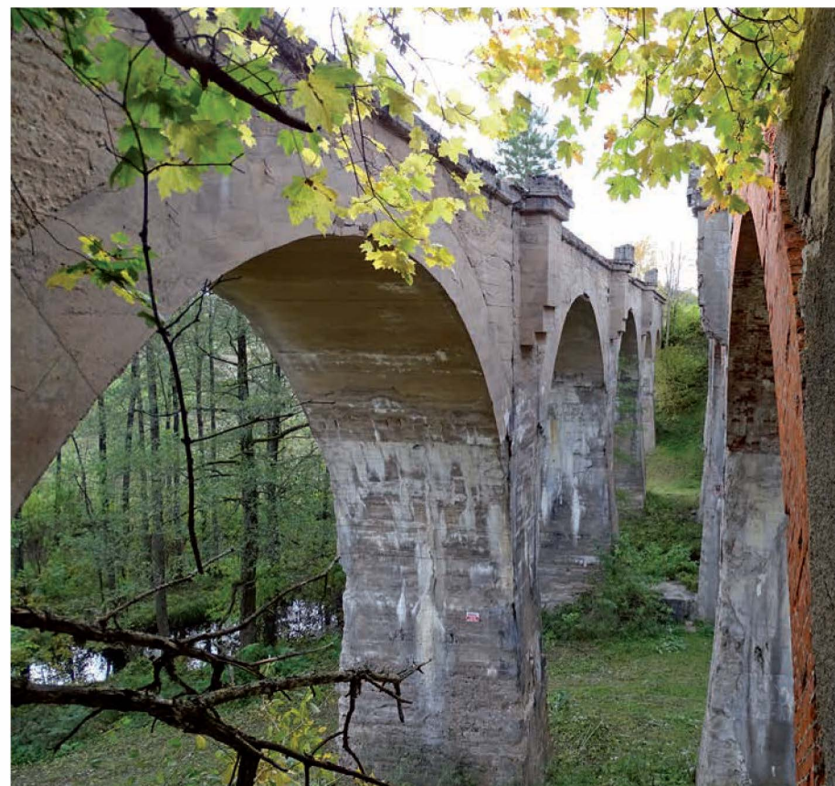
▲ Mosty kolejowe w Kiepojciach: po lewej betonowy z okresu wojny, po prawej przedwojenny z elementami ceglanymi
