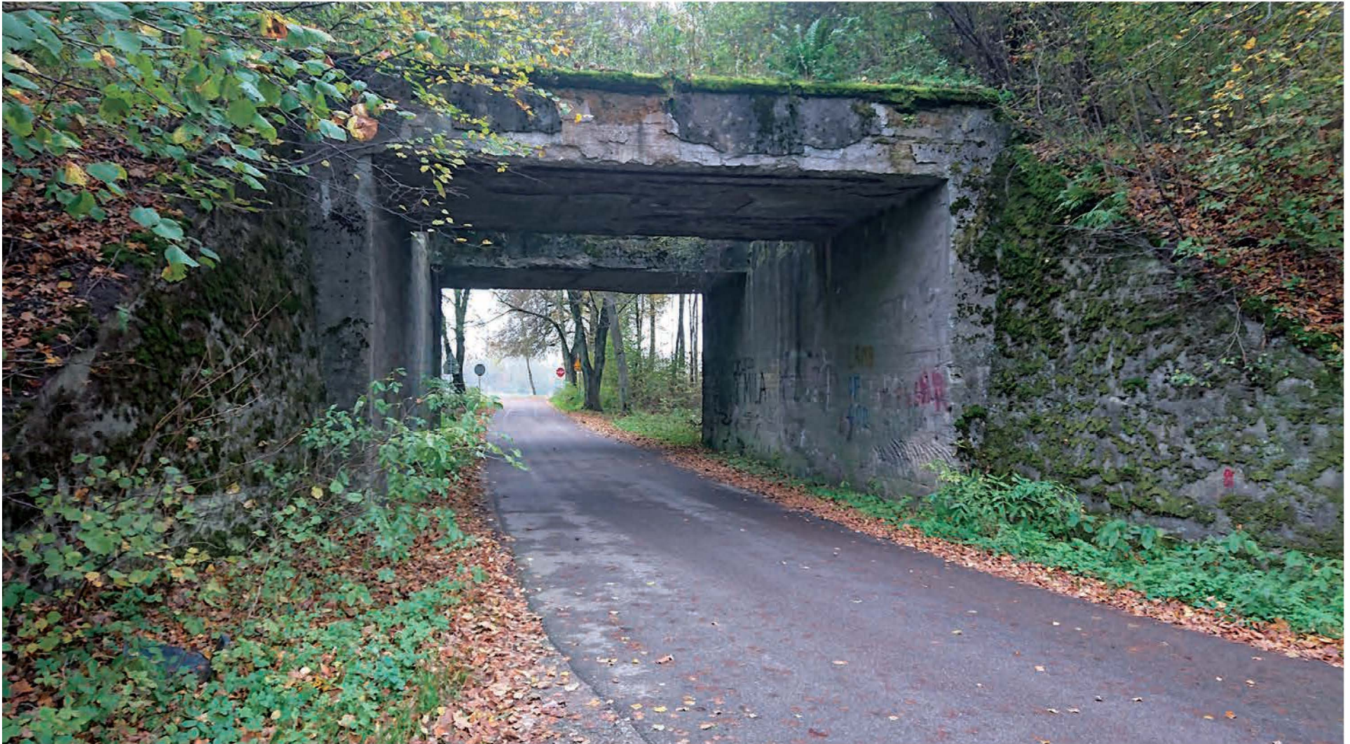
▲ Podwójny, wykonany całkowicie z betonu wiadukt nad lokalną drogą w okolicy Sportyn
