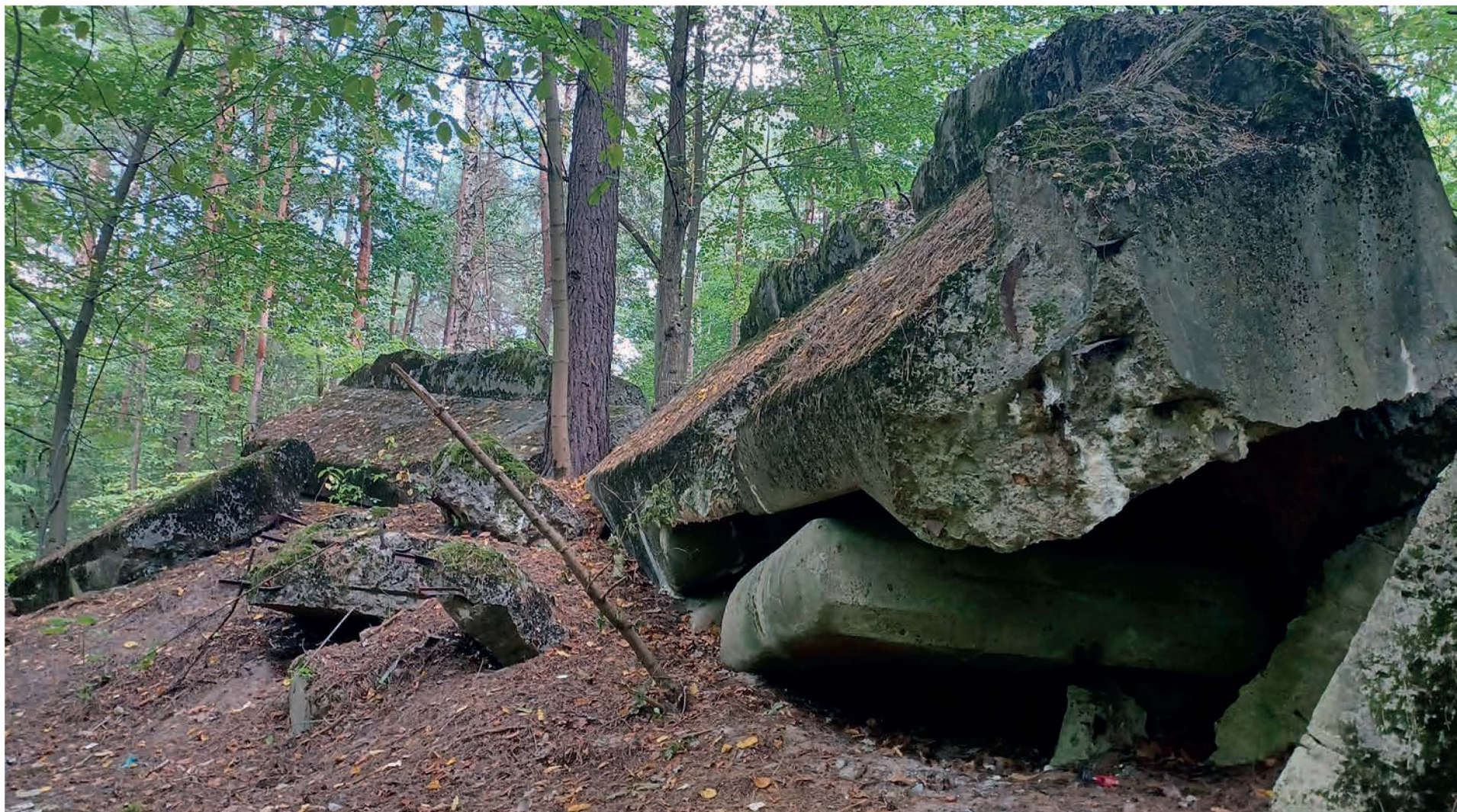
▲ Zniszczony schron niemieckiej linii umocnień z okresu I wojny światowej pod Wiązowną
