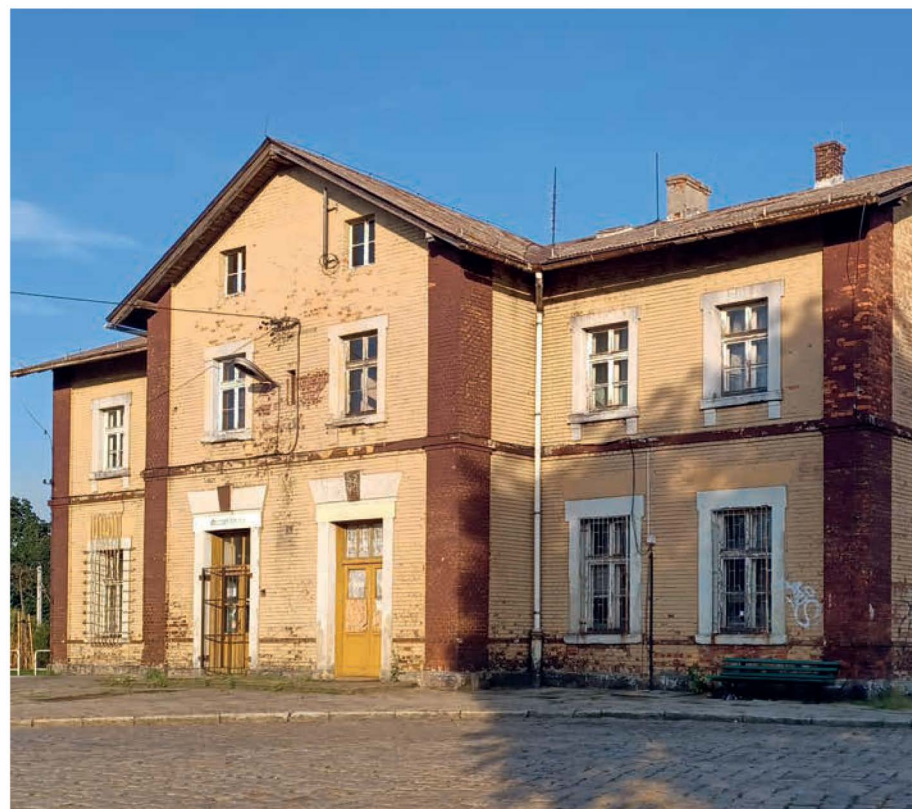
▲ Dworzec w Skoczowie
