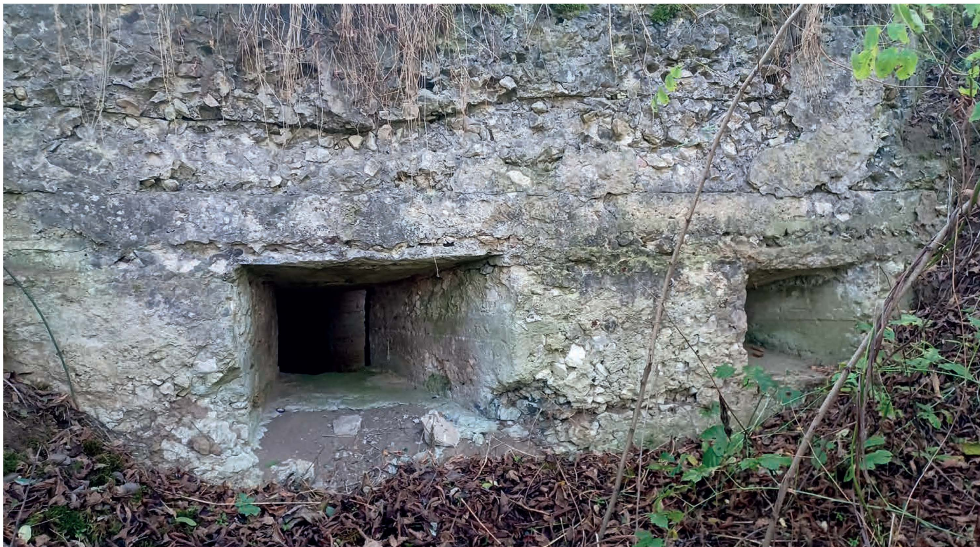
▲ Strzelnice bojowe schronu austriackiej pozycji środkowej Wisły pod Zawichostem
