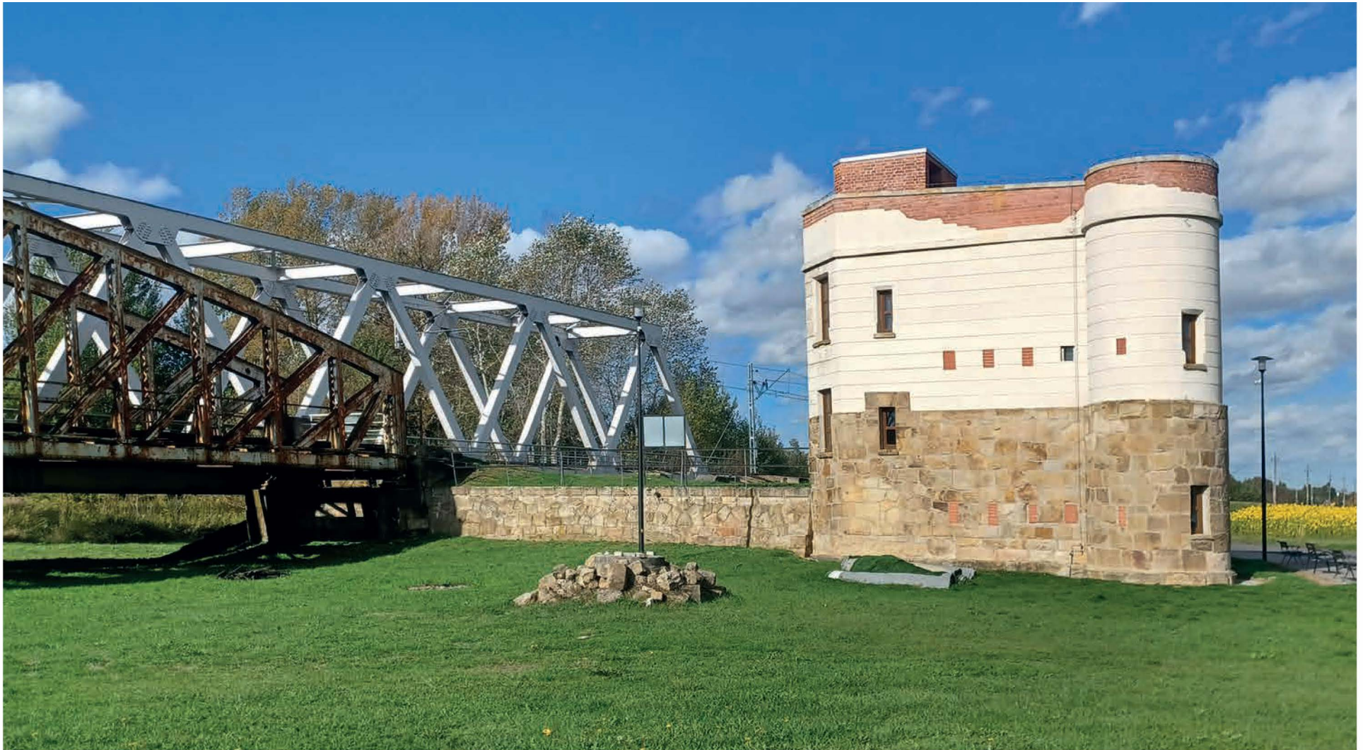
▲ Ufortyfikowana strażnica kolejowa przy moście nad rzeką Wisłok w Tryńczy
