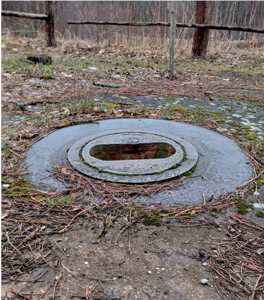
▲ Wybudowany tuż przed wybuchem I wojny światowej na szczycie bastionu Ludwig schron dla peryskopu chronionego pancerzem
