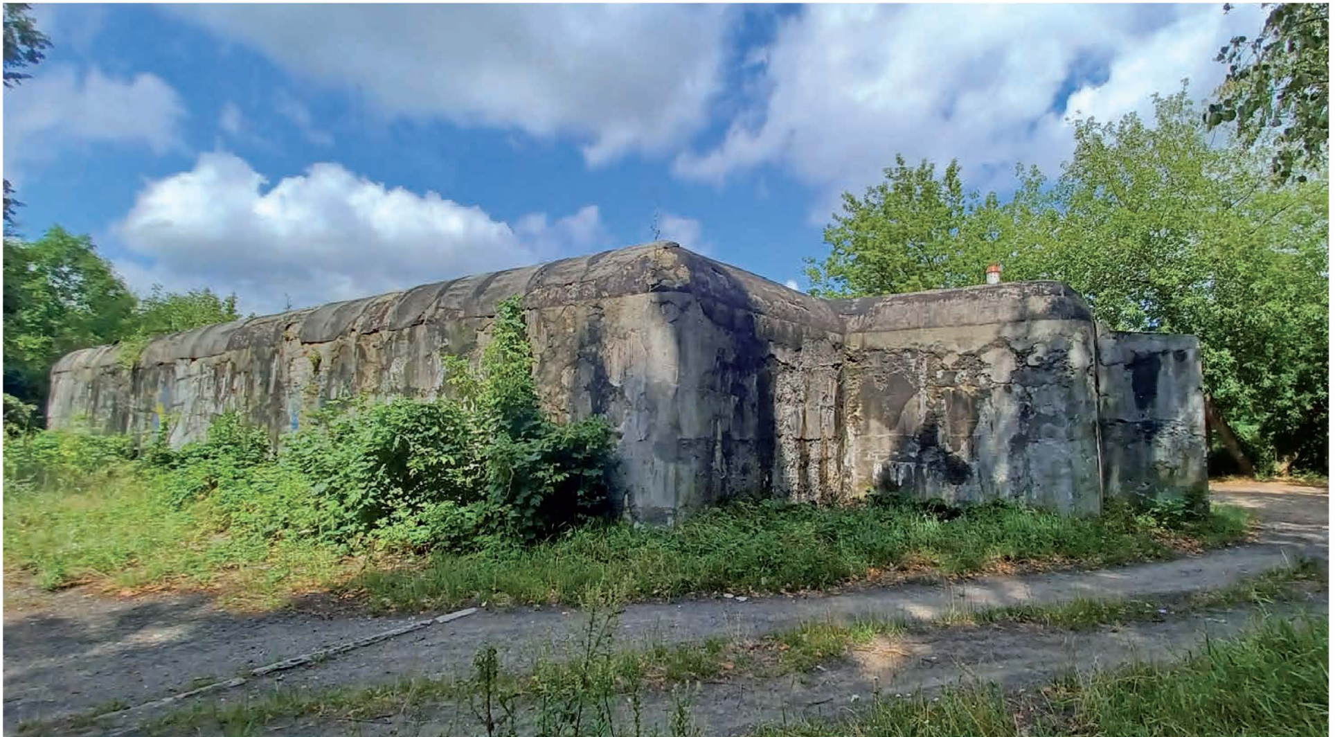
▲ Schron bierny dla piechoty wykonany w 1914 r.; obiekt był obsypany, ale później zdjęto z niego warstwę ziemi, dzięki czemu widać obecnie szczegóły konstrukcyjne
