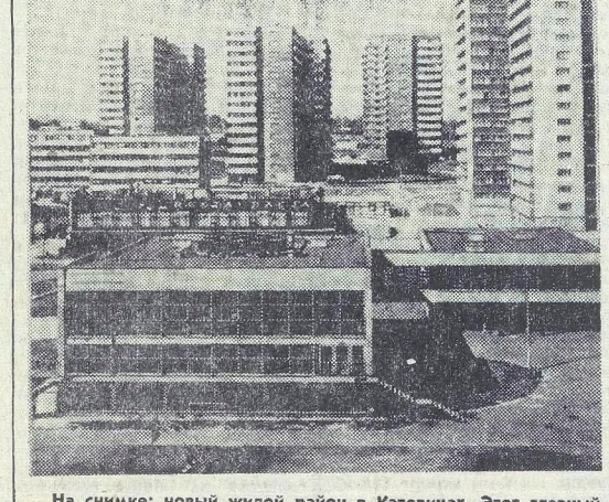
На снимке: новый жилой район в Катовицах. Этот главный город Верхней Силезии называют по-разному: то «столицей угля и стали», то «польским Донбассом», то «самой крупной в стране строительной площадкой».
