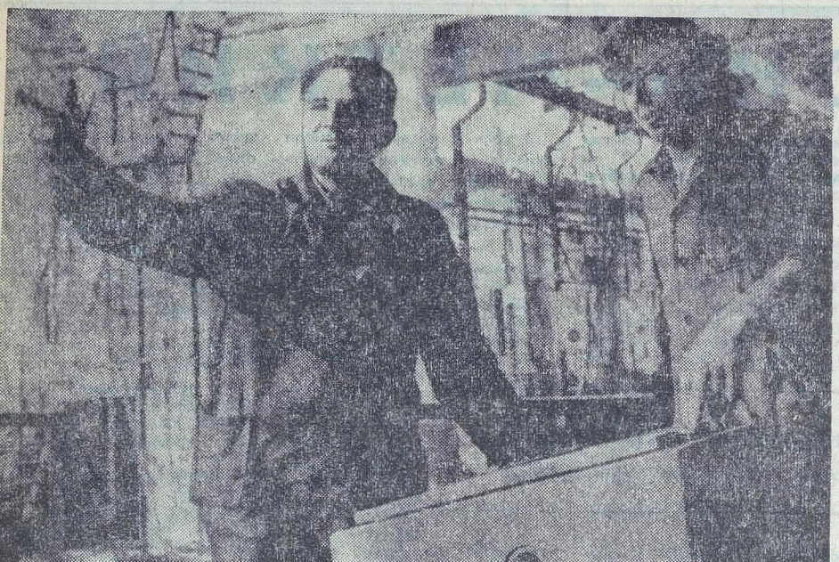
БОЛГАРИЯ. Советский инженер Анатолий МАКАРОВ (слева) и болгарский Стоян СТОЯНОВ работают на строительстве чугунолитейного завода в Ихтимане Софийского округа. Вместе со всем коллективом они соревнуются за досрочную сдачу в эксплуатацию предприятия в честь XXV съезда КПСС и XI съезда БКП.
