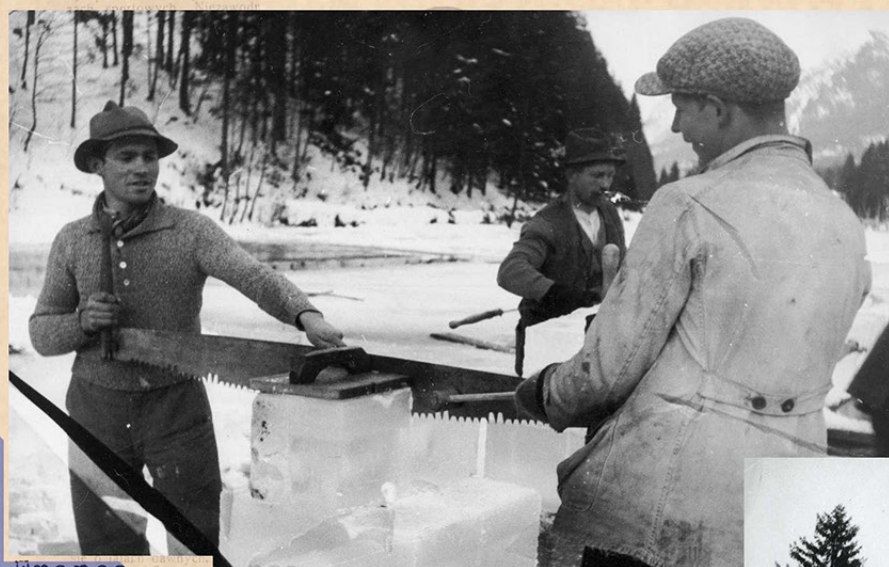
Budowa toru bobslejowego na Zimowe igrzyska olimpijskie w Garmisch-Partenkirchen. Mężczyźni podczas cięcia bloków lodowych-1936r.
