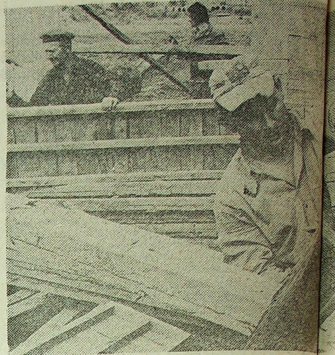
Dobra ściana to najpierw dokładny szalunek. Józef Stadnik, Konstanty Reszezyński i Robert Szygłowski obudowę szalunkową ścian piwnic.
