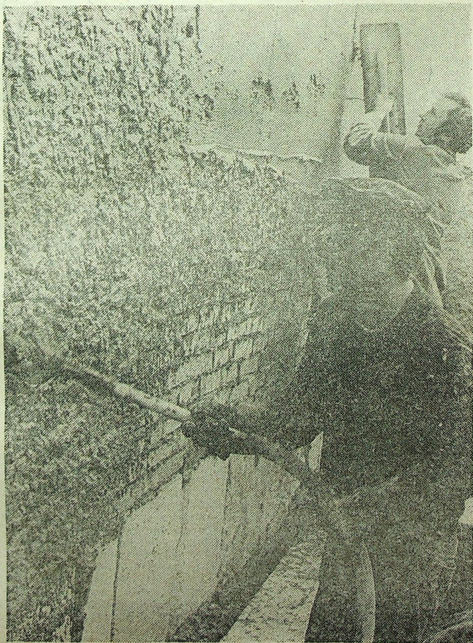
Nawet hydrofornia musi mieć starannie otynkowane ściany. Witold Ostolski i Zdzisław Kłosowicz tynkują szybko i dobrze.
