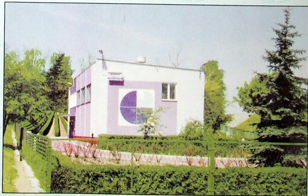
Zakład Uzdatniania Wody Nr 2. Fot. Zbigniew Gol
