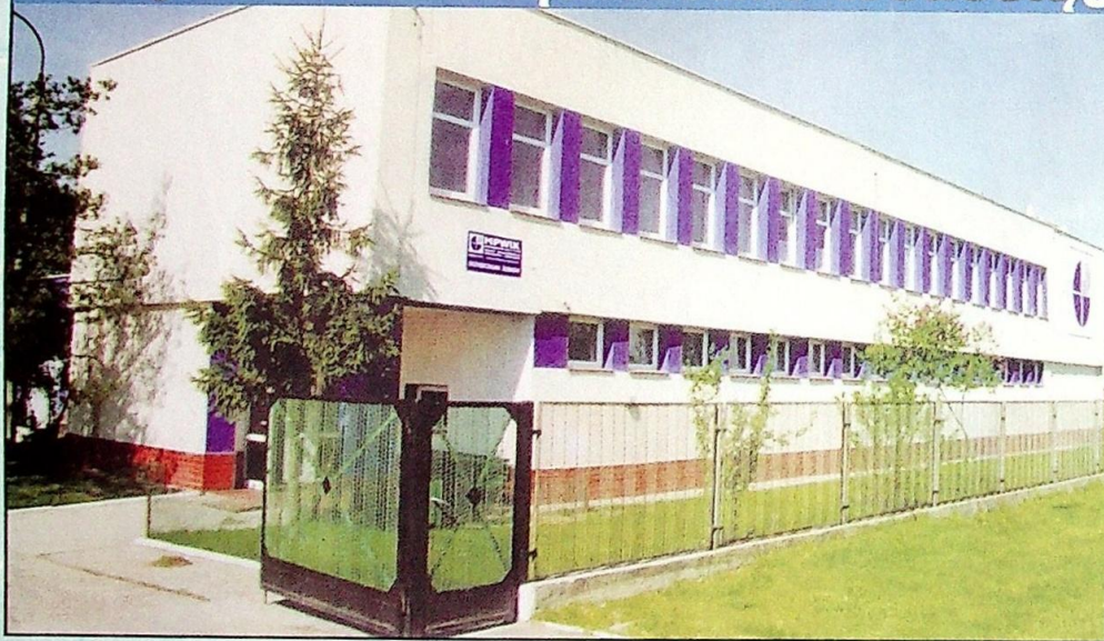
Budynek socjalny oczyszczalni ścieków i laboratorium chemicznego. Fot. Zbigniew Gol
