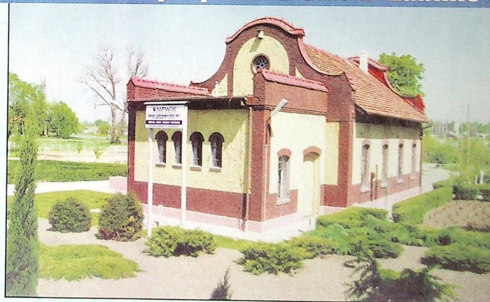
Zakład uzdatniania wody nr 1. Fot. Zbigniew Gol
