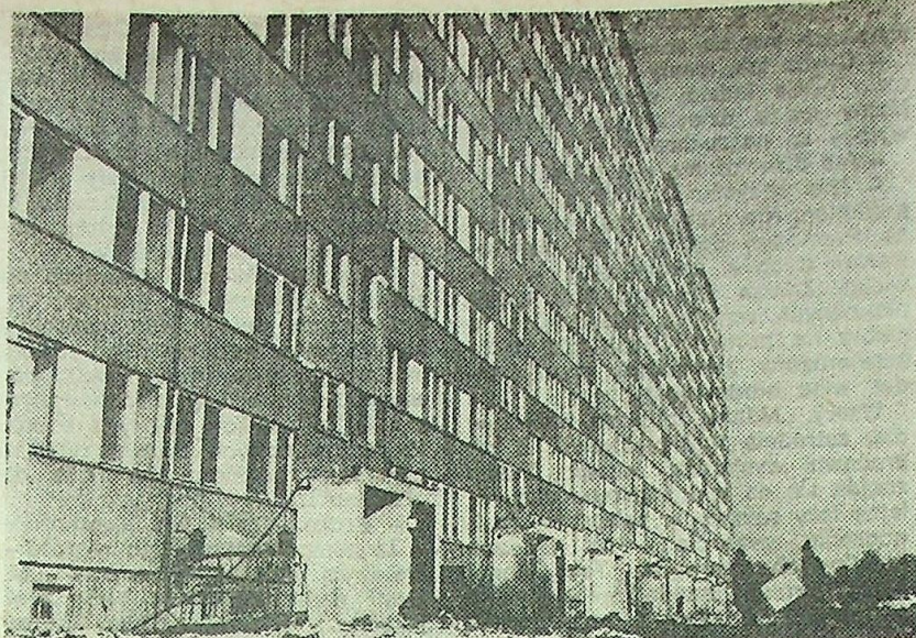
Dolnychczas zasiedlono pięć klatek. W pozostałych czterech trwają roboty wykończeniowe i usuwanie usterek. Fot. Krzysztof Raczkiwiak
