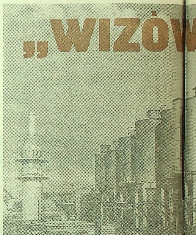
W tej „baterii” zbiorników magazynuje się sodę.
