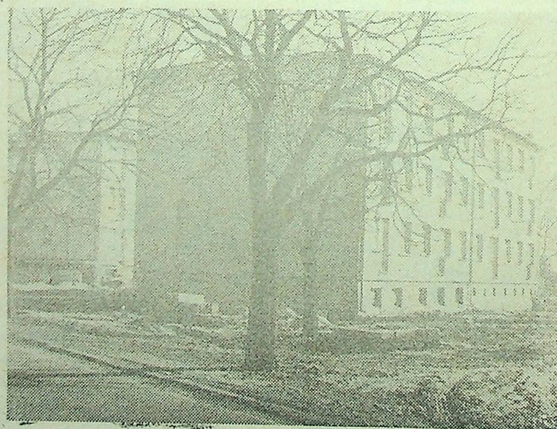
Pierwsze inwestycje mieszkaniowe w Ścinawie są już widoczne. Na zdjęciu: Osiedle domków kombinatu PGR w budowie.
