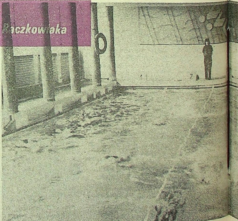
Tak w-f na basenie to marzenie wielu uczniów. W „budowlance” mają to
