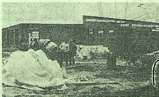
Znaczną część robót przy budowie grębocickiej masarni wykona grupa remontowo-budowlana GS, która jak dotychczas pracuje w szybkim tempie.
