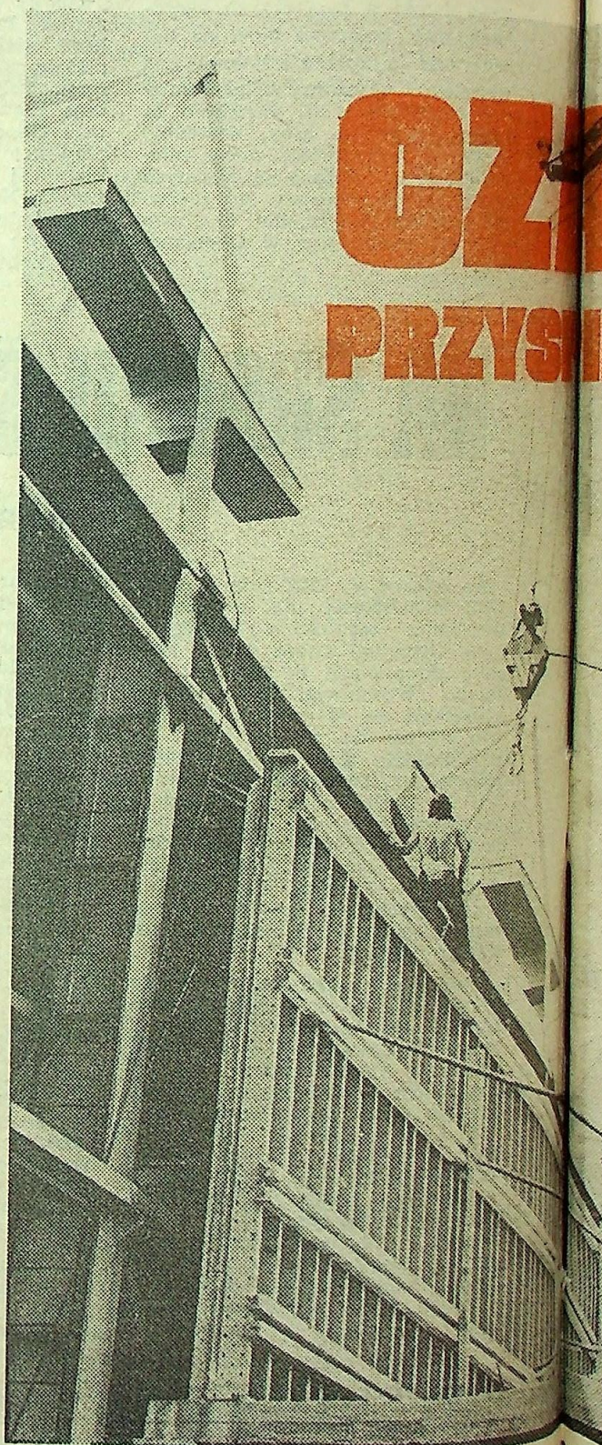
W szybkim tempie rosną ściany wydziału elektorafinacji.
