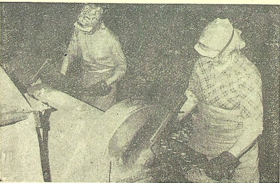
Odlane elementy wymagają oszlifowania. W tej pracy liczy się kobieca dokładność. Przy szlifierce Teresa Barnowska i Maria Matyewicz.
