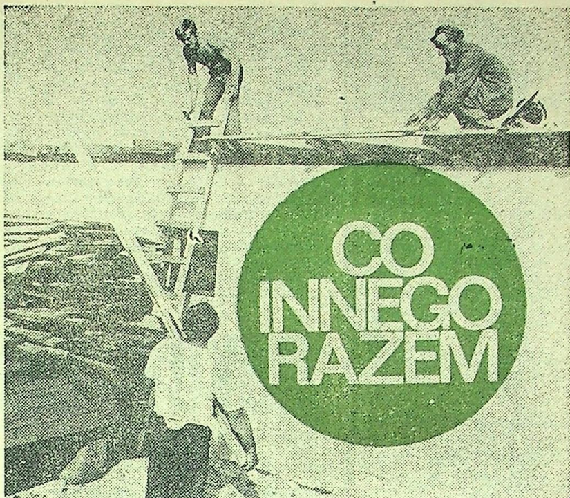
Cieśle budowlani: Piotr Konieczny, Ireneusz Dziopa i Tadeusz Kapuściński kładą dach na nowych kurnikach. — „Chcemy je wykończyć do pierwszego grudnia”.
