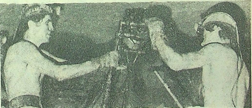
Jednym z podstawowych warunków osiągnięcia w tym 5-leciu 75-procentowego wzrostu produkcji miedzi jest zakończenie rozbudowy kopalni „Lubin” i „Polkowice” przynieszone doświadczenia do projektowania zdolności produkcyjnej przez „Rudną” i rozpoczęcie budowy „Sieroszowic”. Fot. K. Raczkowiak
