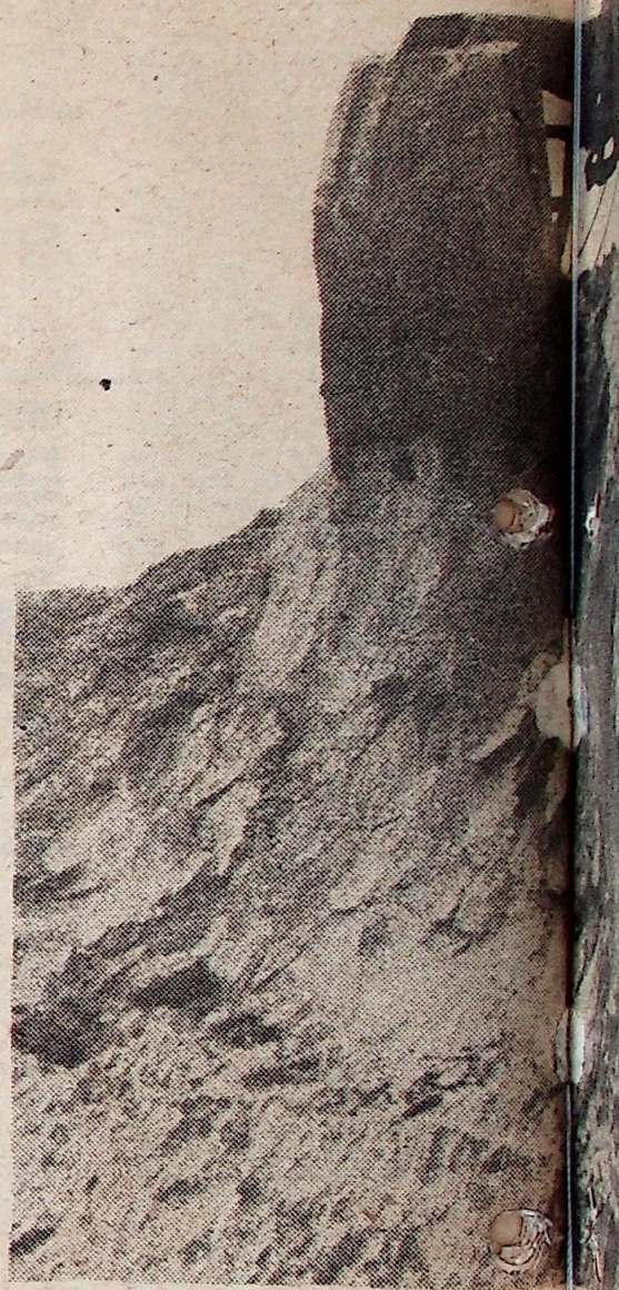
Powstaje wykop pod fundamenty budowlany, która wykorzysta się pod
