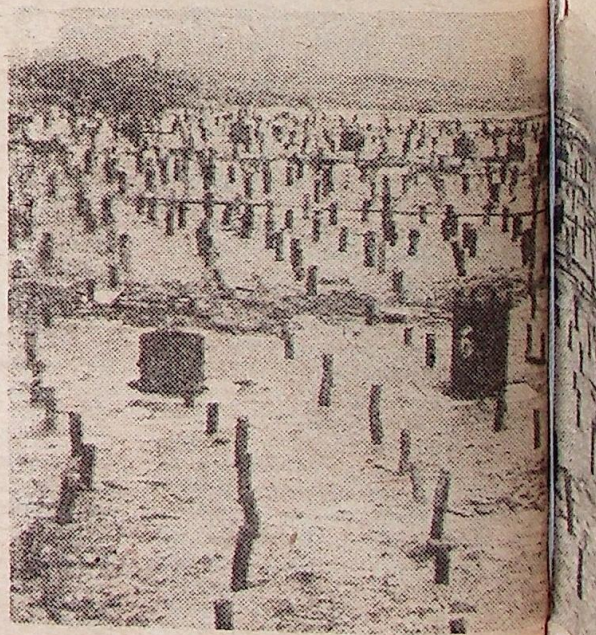
Widoczna na zdjęciu betonowa płyta już ustawiona w tym miejscu wieży wiertniczej. Długość, sięgających głębokości 400 m.
