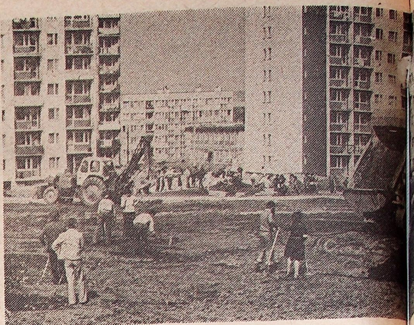
Głównym zadaniem tegorocznego Czynu Partyjnego w Lubinie było wybudowanie osiedla na Przylesiu.
