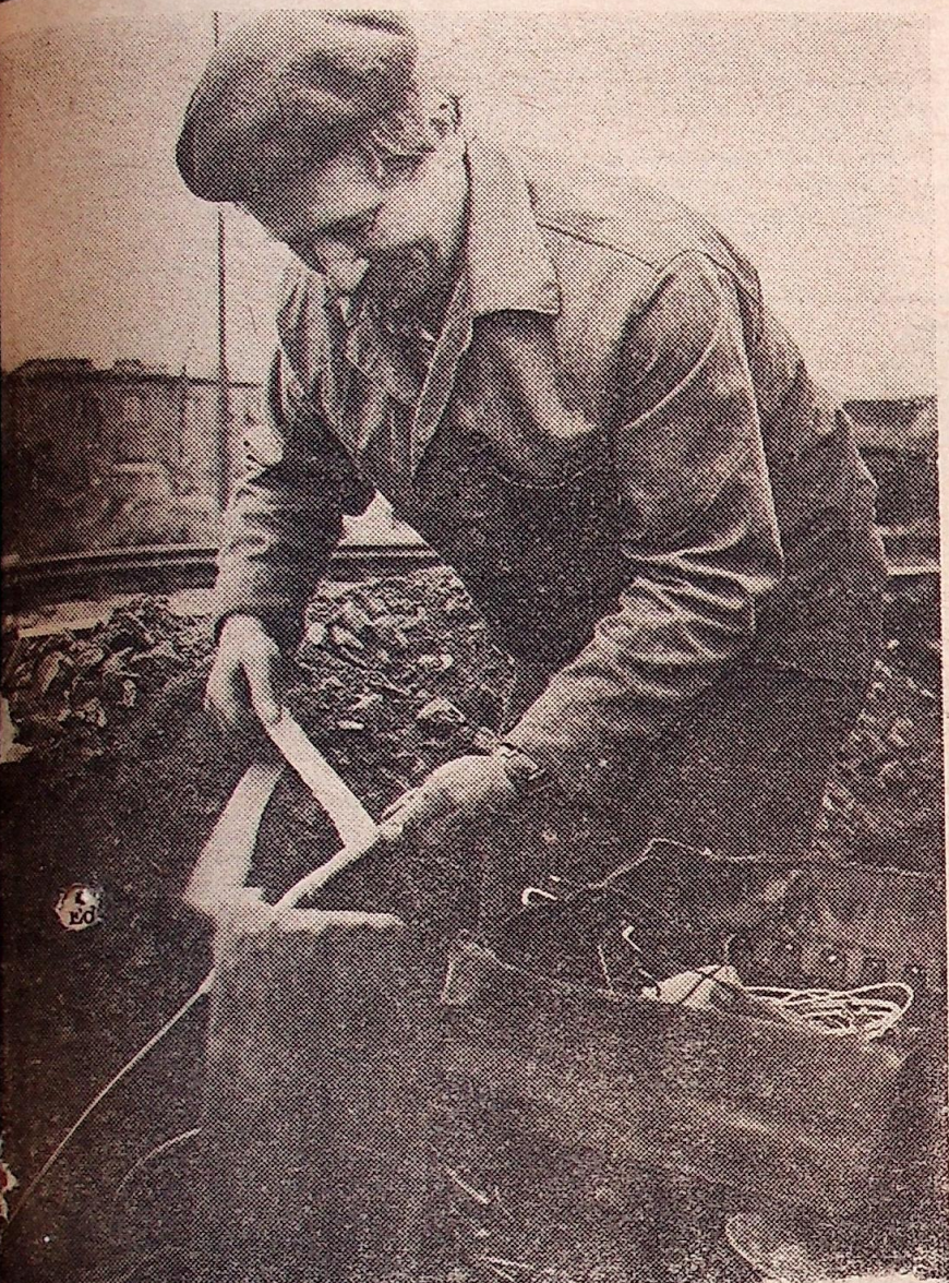
ale modernizuje się łączy manewrowe legnickiej stacji PKP. Stanisław ka układa kabel do nowej tarczy manewrowej.
