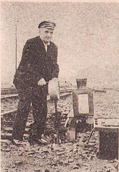
Przez trzynaście lat Zygmunt Urbaniak ręcznie przekładał „wajchę”. Teraz wystarczy nacisnąć guzik i w kilka sekund układa się automatycznie droga przebiegu pociągu.
