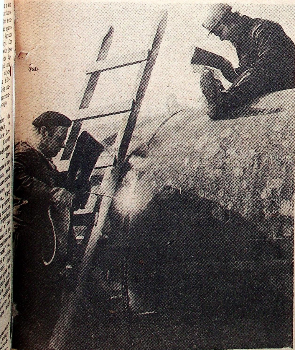
Praca spawania wymaga precyzji, dokładności i doświadczenia. Henryk Zajac i Władyslaw Nawrocki z PBMH spawają nogi wieży skipowej.
