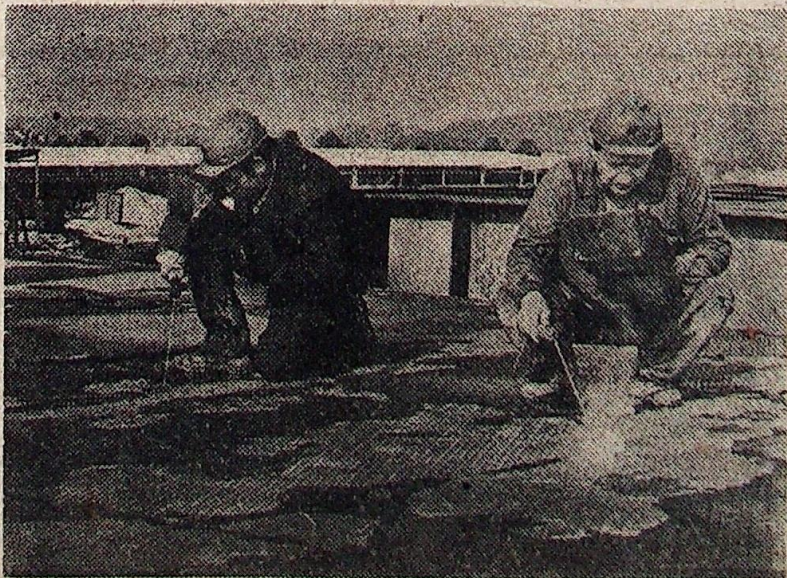
Przy spawaniu pomostu wieży skipowej Jan Kaczmarezyk i Stefan Kaliski.
