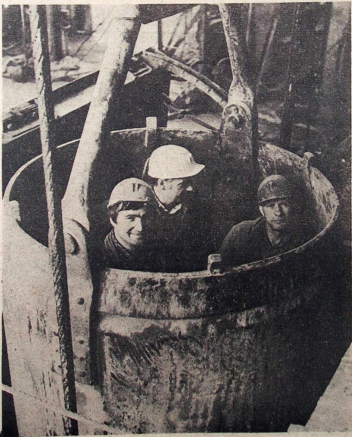
W kuble: Edward Jaworek, Tadeusz Tomczak i Józef Jarosz z PBKR Lubin zjeżdżający właśnie do głębionego szybu SW-3 w Zakładach Górniczych „Sieroszowice”. Fotoreportaż z budowy najmłodszej miedziowej kopalni zamieszczamy na str. 8—9. Fot. Krzysztof Raczkowski
