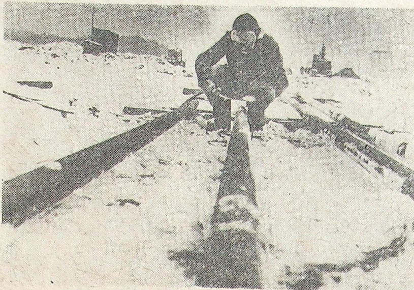
Ryszard Bober spawa rurociąg c.o. do stacji uzdatniania wody.
