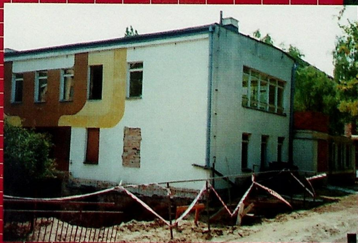
Kapitałny remont żłobka przy ulicy Cedyńskiej
