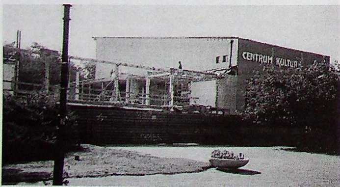
Przystąpiono do drugiego etapu modernizacji Centrum Kultury „Muza”
