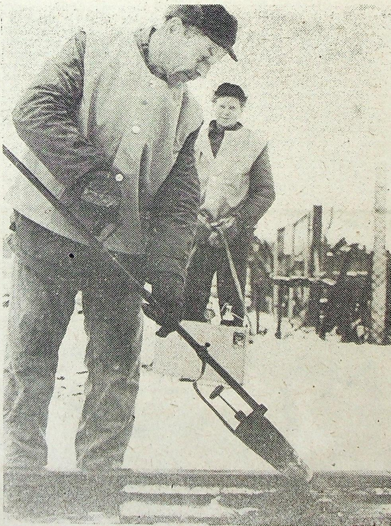
Rozjazdy są najważniejszym ogniwem kolejowej sieci. Wią o tym Władysław Warchol, który po kolei odmraża je benzynowym aparatem.
