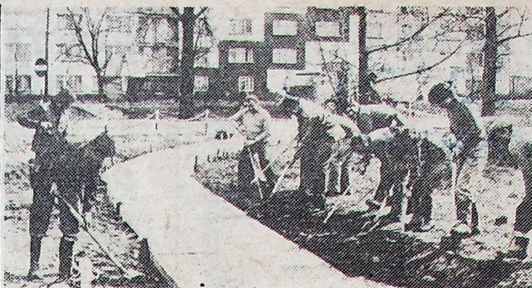
Pracownicy Przedsiębiorstwa Budowy Kopalń z Bytomia w czynie społecznym dla uczczenia zbliżającego się Święta Pracy ułożyli (12 bm.) w pobliżu hoteli robotniczych w Polkowicach nowy chodnik.
