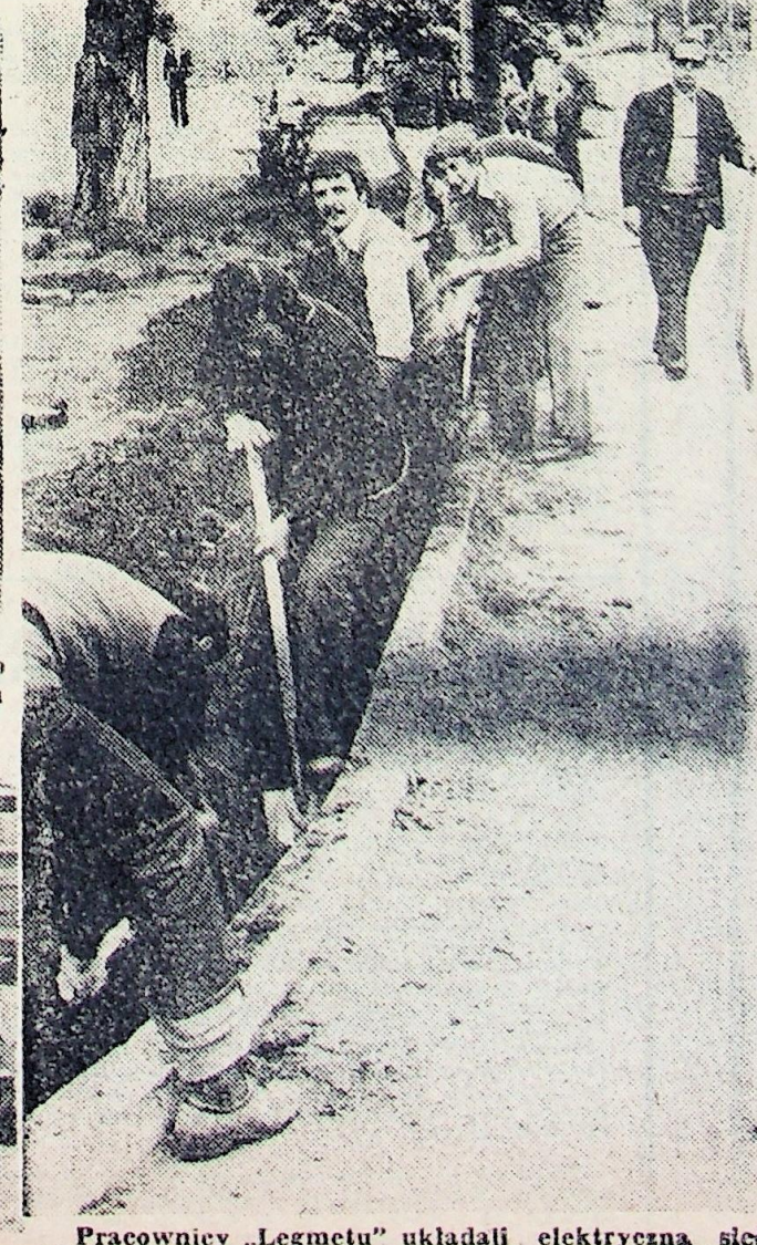
Pracownicy „Legmetu” układali elektryczną sieć kablową na ul. Chojnowskiej w Legnicy.
