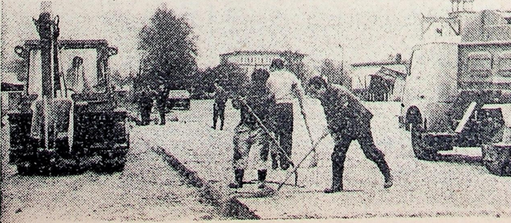
Górnicy ZG „Konrad” budowali parking w Iwinach.
