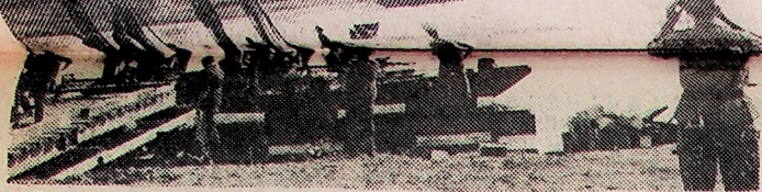
Początek budowy. Do zamknięcia mostu pozostało 150 metrów.
