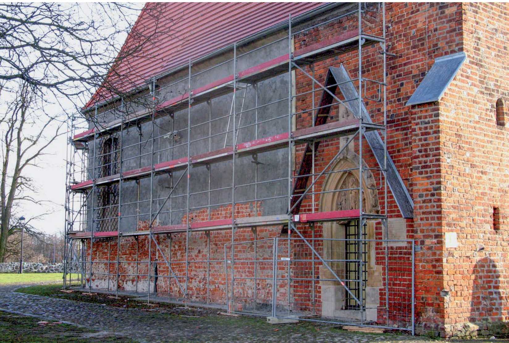
Remont elewacji Galerii Zamkowej (III 2010 r.), fot. Piotr Bieruta
