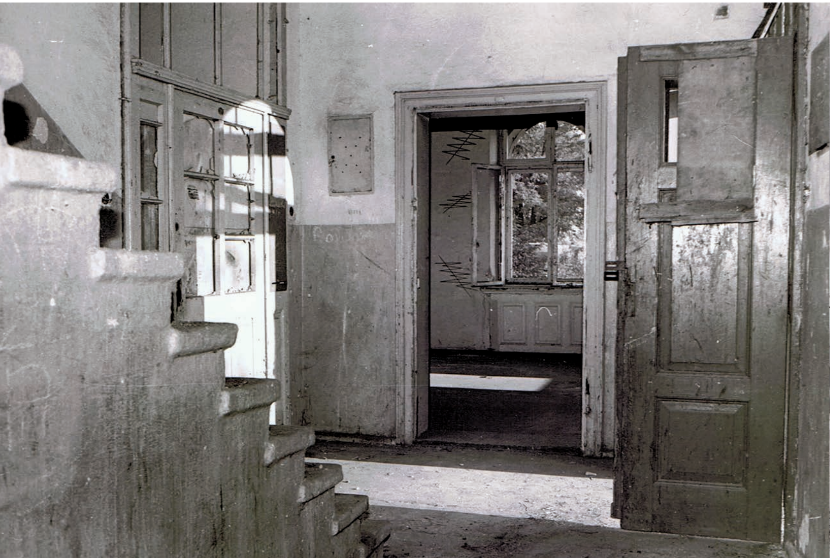
Kamienica przy ul. Piastowskiej 15, przed adaptacją na siedzibę Ośrodka Kultury „Wzgórze Zamkowe” (1986 r.), fot. Jerzy Kosiński
