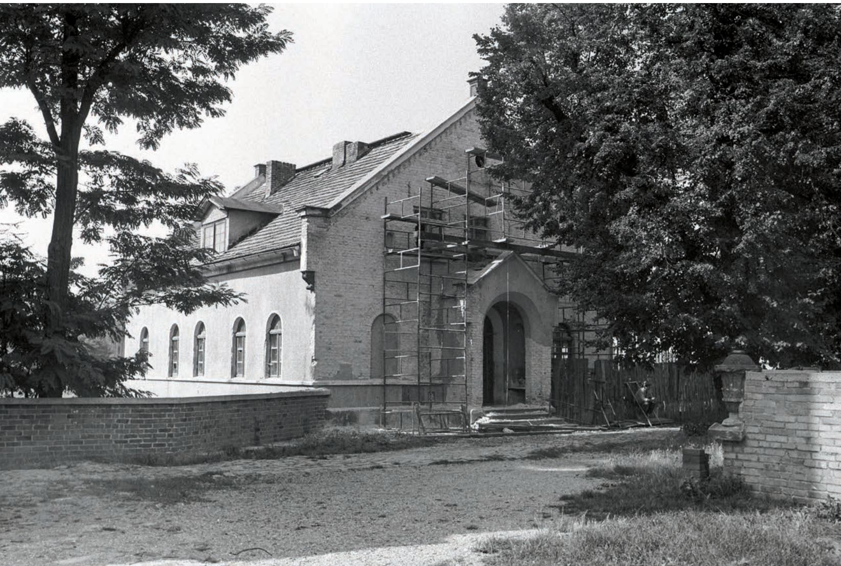
Kamienica przy ul. Piastowskiej 15, przed adaptacją na siedzibę Ośrodka Kultury „Wzgórze Zamkowe” (1988–1989 r.), fot. Jerzy Kosiński
