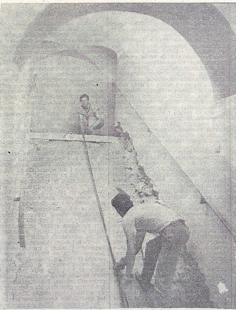
Na remont jednego piętra — choć stosowniej byłoby powiedzieć odbudowę — potrzeba około 75 mln zł. Fot. Wincenty Kołodziejczyk
