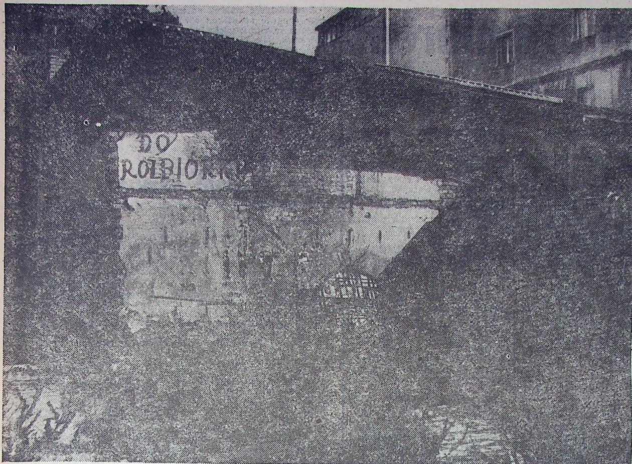
„Woda płynie wartko, choć mnóstwo wszelkiego śmiecia tworzy jedyną w swoim rodzaju tamę. Na budynku dawnej elektrowni ktoś napisał farbą: „Do rozbiórki”.
