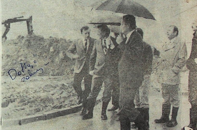
Osiedle Zalesie w Złotoryi. Trzeba sięgać wysoko — nawet w wykopie pod fundamenty. Zdj. Wincenty Kołodziejcki
