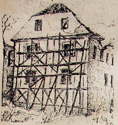
Zamiast sgraffitów ścianę renesansowego dworu „zdobia” dziś tylko rusztownia.
