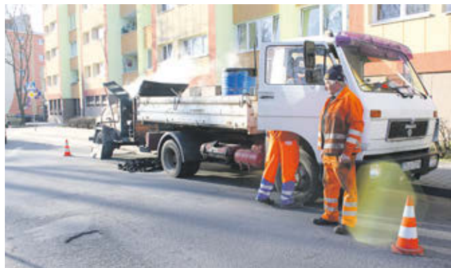
W mieście trwa właśnie łatanie wyrw w ulicach
