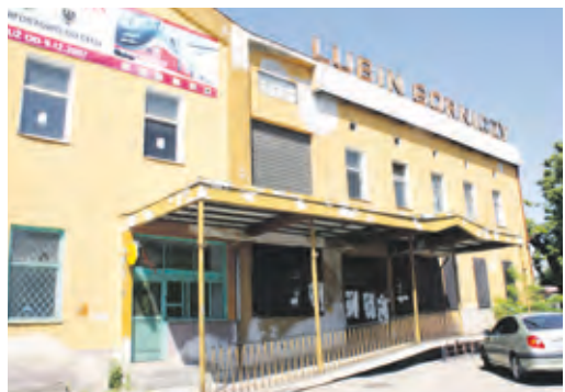
Ogłoszono przetarg na wyburzenie dworca
