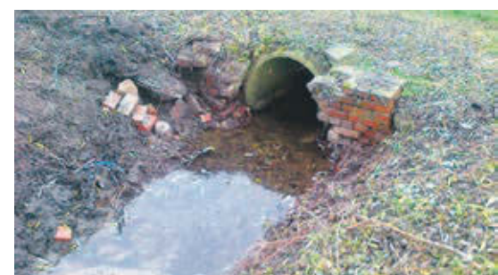
Efektom prac są oczyszczone rowy melioracyjne oraz sześć przepustów w Tymowej i Jurcu
