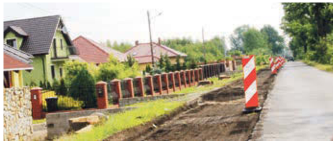
Droga równocześnie remontowana jest z dwóch stron – od Karczewisk do Raszówki i od strony Miłosnej do Miłoradzie
