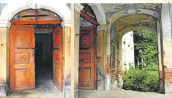
Główne wejście do pałacu
