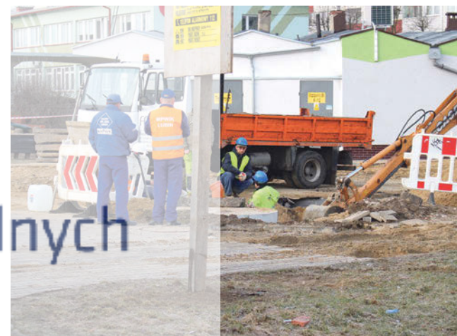
Na ulicy Mickiewicza przebudowana zostanie jezdnia, a także zatoki autobusowe, miejsca postojowe, zjazdy i chodniki, kanalizacja deszczowa oraz oświetlenie
