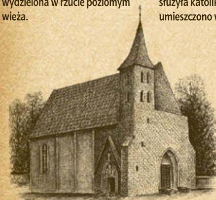
Widok kaplicy od strony północnej
