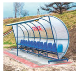
Ścinawski magistrat sfinalizował zakup boksów dla zawodników rezerwowych, które zamontowano na początku marca tego roku
