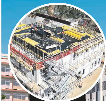
Ostatnio wylano strop nad parterem, stanowiący jednocześnie podłogę dla pierwszego piętra
