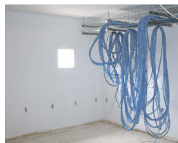
Część instalacji jest już gotowa
