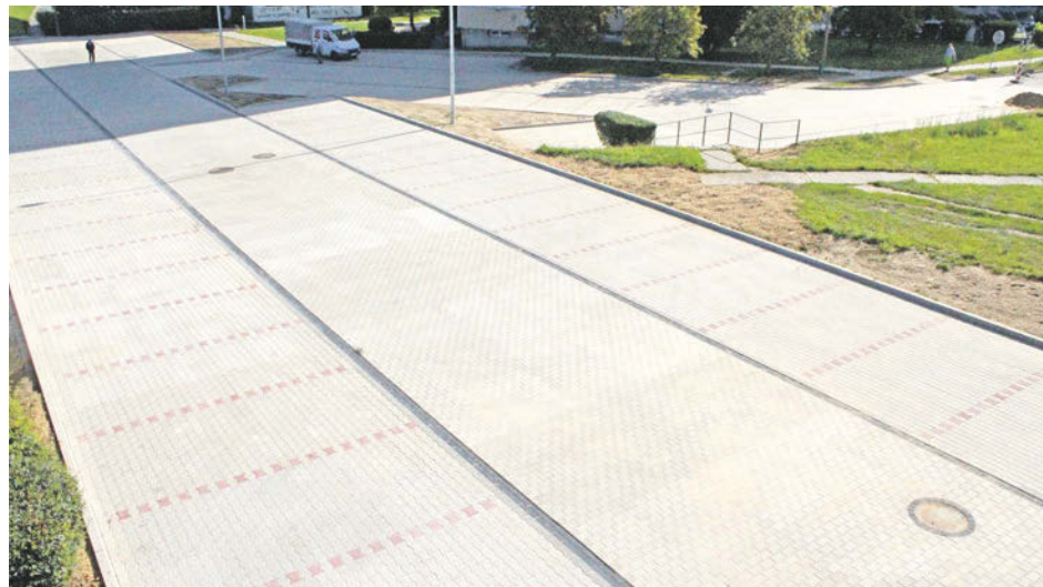
W sumie przy ulicy Topolowej 52 powstało około 82 nowych miejsc parkingowych
