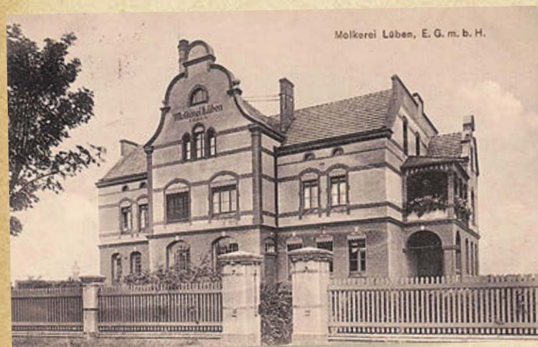
BUDYNEK MLECZARNI PRZY OBECNEJ UL. CHOCIANOWSKIEJ
