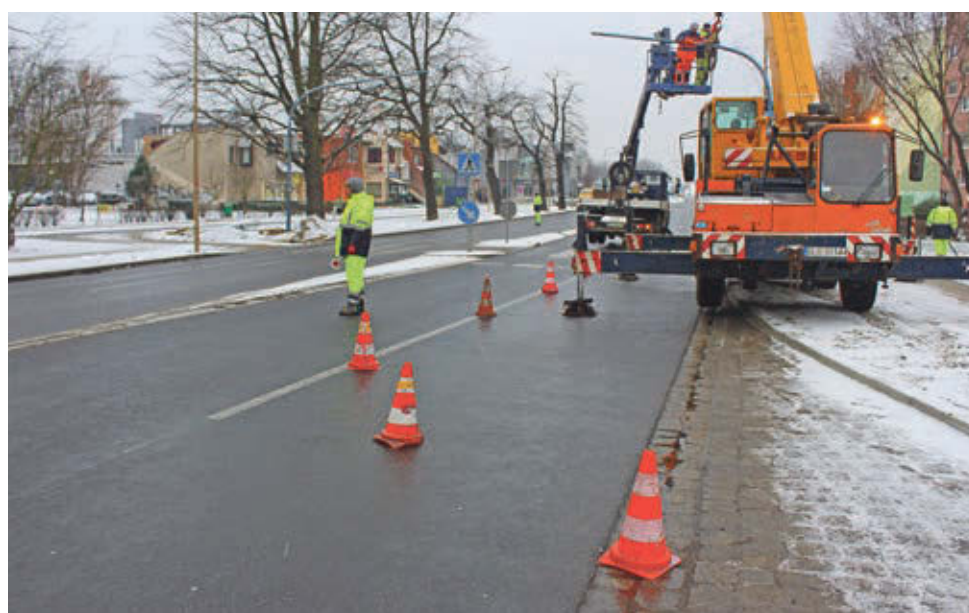
Do wykonania pozostały jeszcze m.in. budowa nowych i przebudowa istniejących sygnalizacji świetlnych
