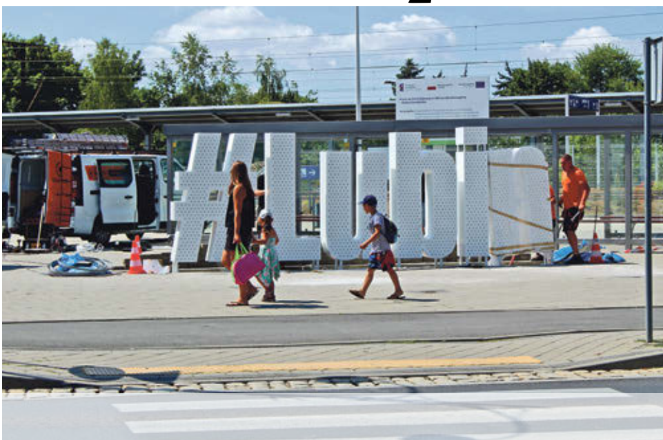
Konstrukcja wykonana jest z aluminium. Najwyższy punkt ma 2 metry, a całość 6,30 długości
