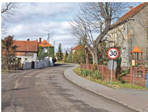
Wykonawca ma oddać remontowany fragment najpóźniej do końca maja
